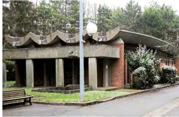
Bâtiment N, entrée nord, à réhabiliter
