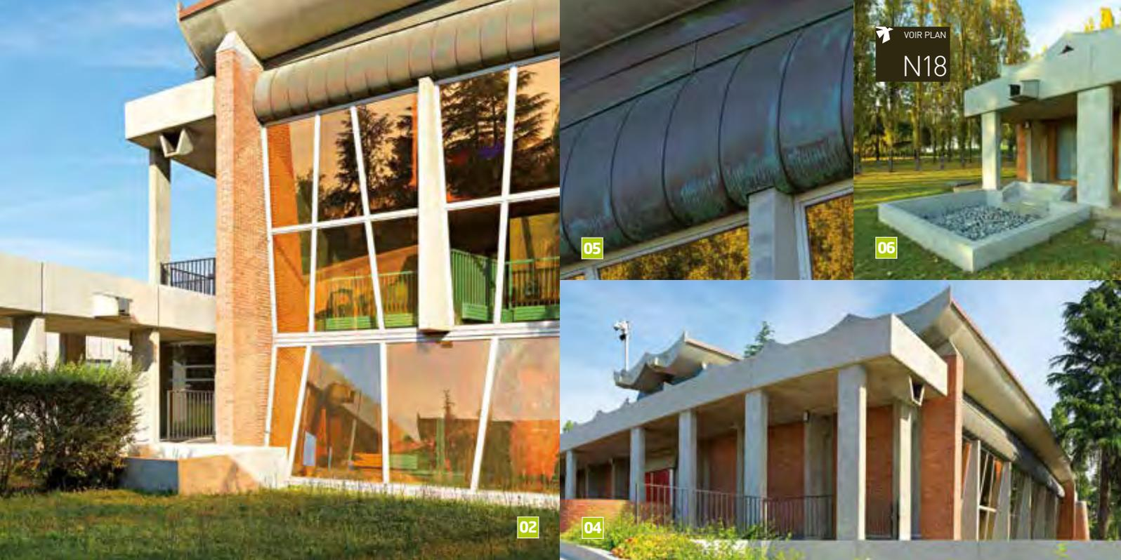
La préfabrication est ainsi étendue aux poteaux, murs, allèges... de béton et de briques (près de 200 éléments ont été fabriqués sur place). L'articulation des coques et des murs est réalisée par des couvre-joints en cuivre, en forme de goutte d'eau **05**. Pour Auzelle, c'est de cette rencontre de techniques et de matériaux qu'émanent la qualité architecturale et l'unité des édifices.
